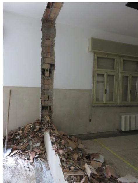
doppia parete di forati (di altezza di m 3,40) con una intercapedine di aria interposta (come da schema sottostante). Alcune di queste pareti sono state demolite (e poi ricostruite come murature omogenee in laterizio sismico) nel 2017 in occasione dell'intervento di miglioramento sismico (vedi foto nella pagina precedente a destra).
