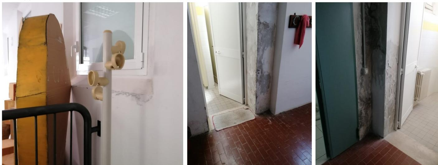
Verrà pertanto eseguita la rimozione degli intonaci ammalorati, la posa di intonaco deumidificante, la ritinteggiatura con prodotti traspiranti.
